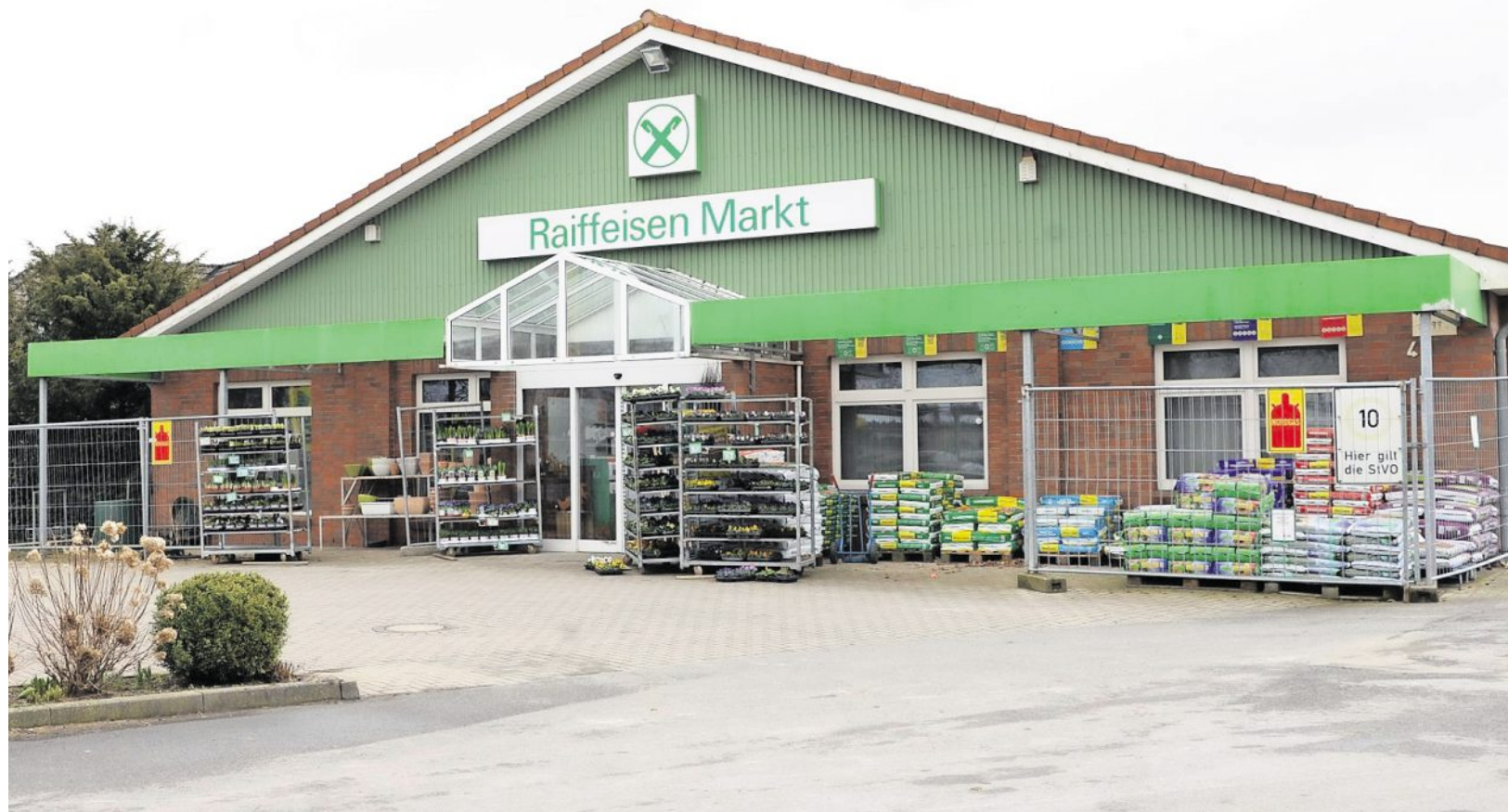
Der Raiffeisenmarkt in Lamstedt (Archivbild) wird derzeit umgebaut. Im April soll er neu eröffnet werden.
